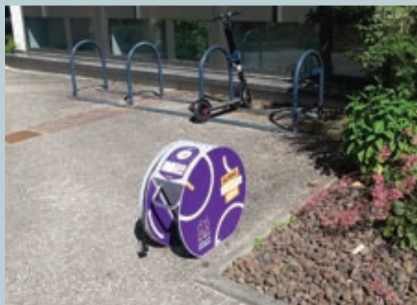
Une station de gonflage a été installée devant la mairie. Disponible en libre accès.
