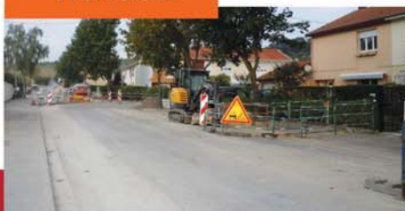
L'avenue du Général de Gaulle en travaux
