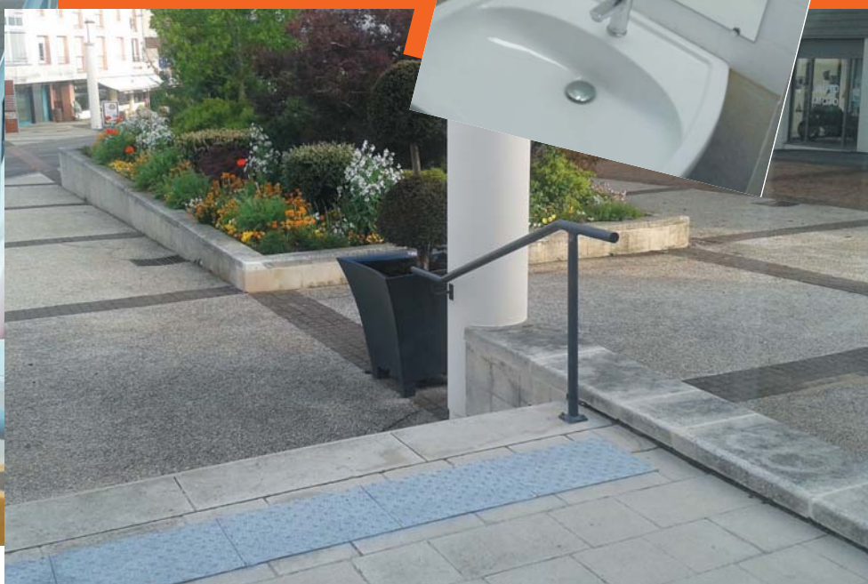
Nouvelle main-courante sur le parvis de la Mairie et pose de bandes podotactiles
