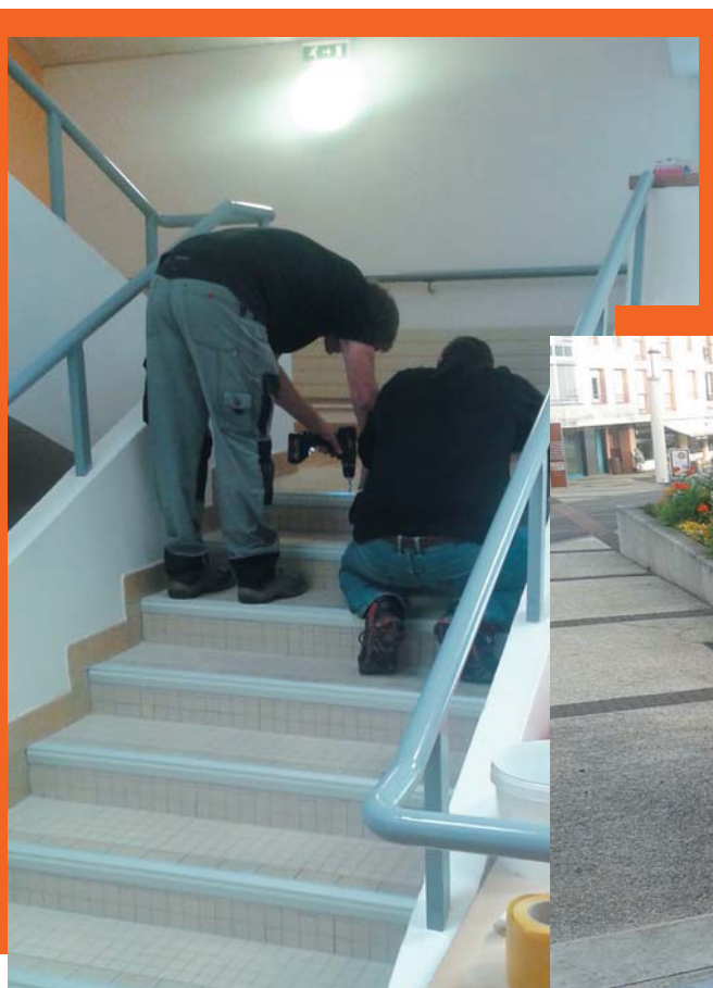
Mise aux normes des escaliers de la Maison de l'Amitié
