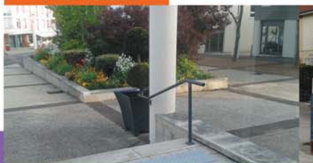
Mise en accessibilité des bâtiments
