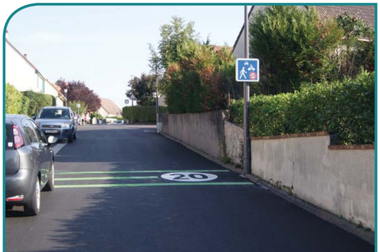
Mise en place de la signalisation de la zone de rencontre.
